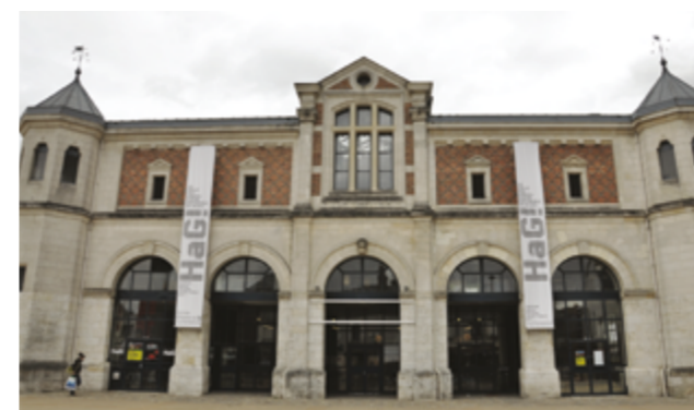
Halle aux grains de Blois © 52e2, Région Centre-Val-de-Loire
